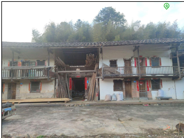
传统风貌建筑，建议传统风貌建筑
