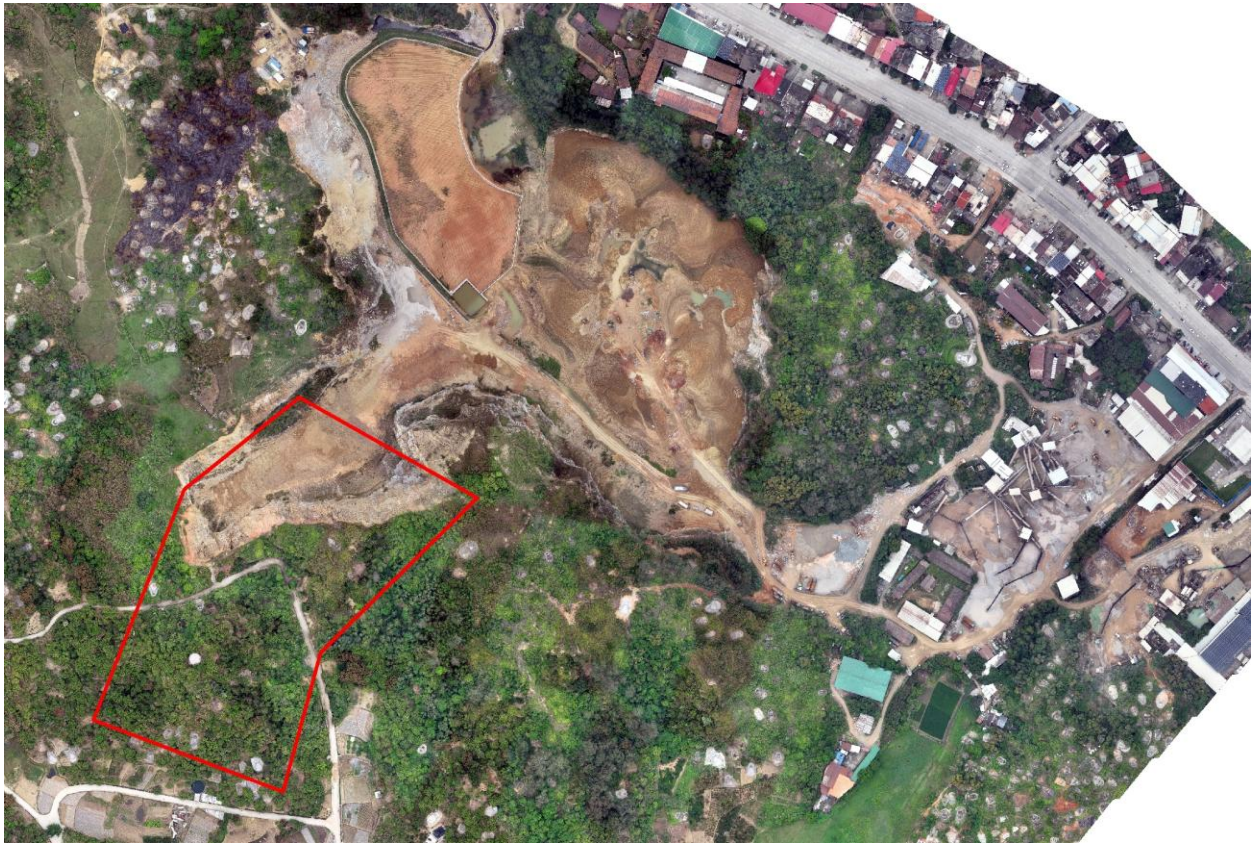
图1-2 矿山采坑现状
